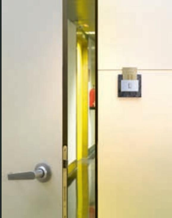
**Новые карточные выключатели.** Механические и с задержкой отключения, причём последние оснащены потенциометром, который позволяет задавать время, в течении которого свет продолжает гореть после изъятия карты.
