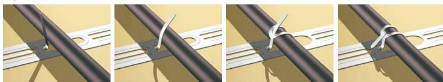
Замість стрічки можна використати металеву або пластикову сітку з розміром клітинки не більше 5 см, до якої кабель кріпиться за допомогою хомутів або зажимів. З метою захисту кабелю від пошкоджень, роботи проводьте у взутті з м'якою підошвою.
